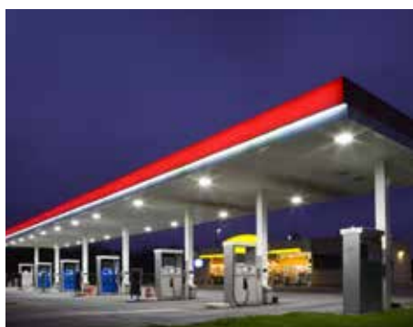
STAZIONI DI SERVIZIO
